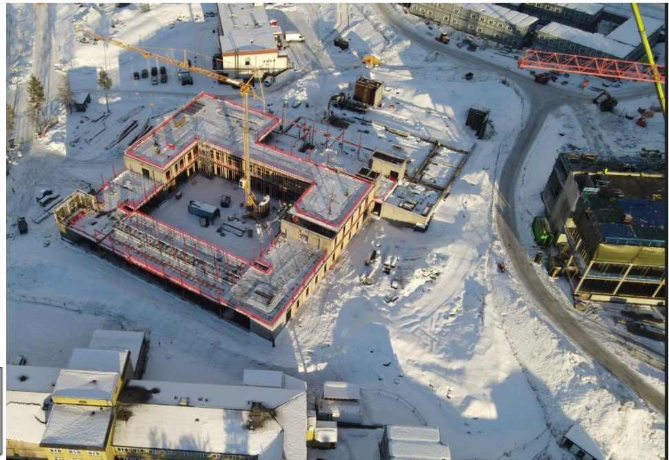
Psykiatri- og habiliteringsbygget, januar 2023
